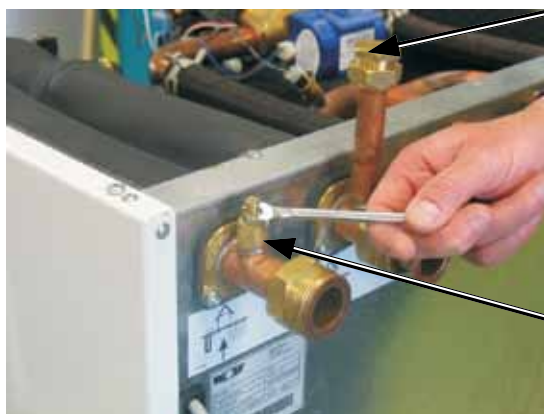
ručný odvzdušňovací ventil vo vstupe soľanky
